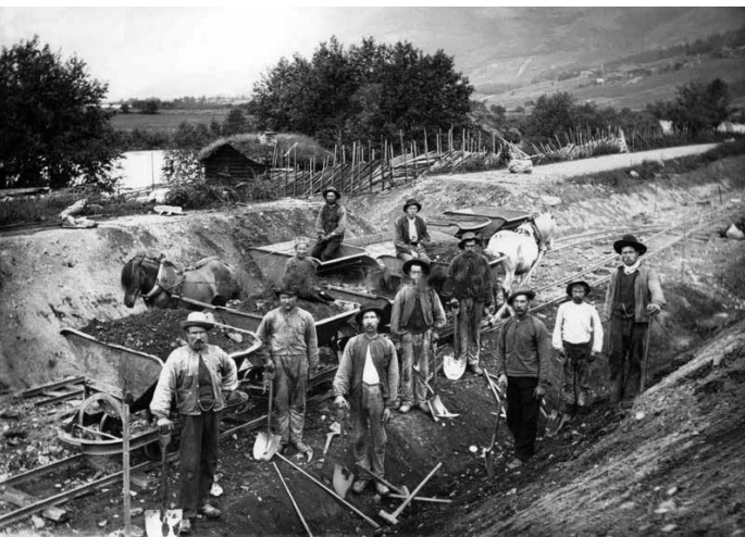
Dovrebanen gjennom Gudbrandsdalen, med arbeidslaget til Hans H. Kirketeigen fotografert på Kvam i Nord-Fron i juni 1896.
