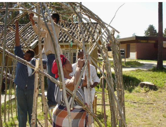
Bygging av hytte, Glomdalsmuseet 2005.
